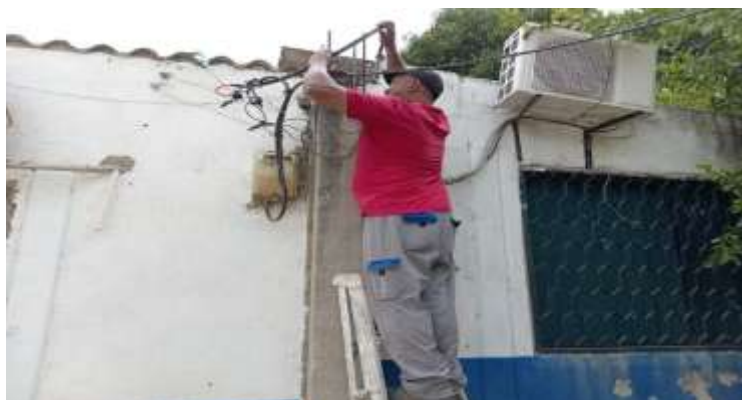
Adecuaciones y arreglos de las instalaciones eléctricas
