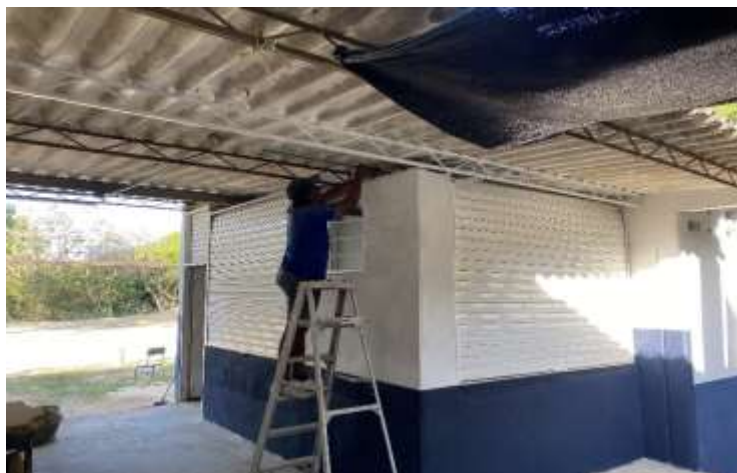
Pintura de techo y paredes
